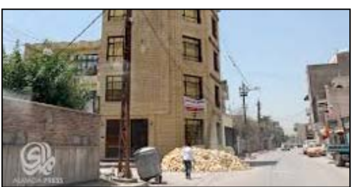
شقق سكنية تم بناؤها على النقاض منزل تم هدمه في احد ارقعة منطقة الكرادة (عدسة. محمود زورف)
